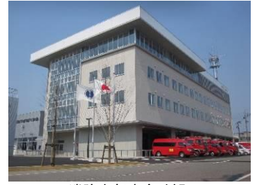
消防本部庁舎外観
