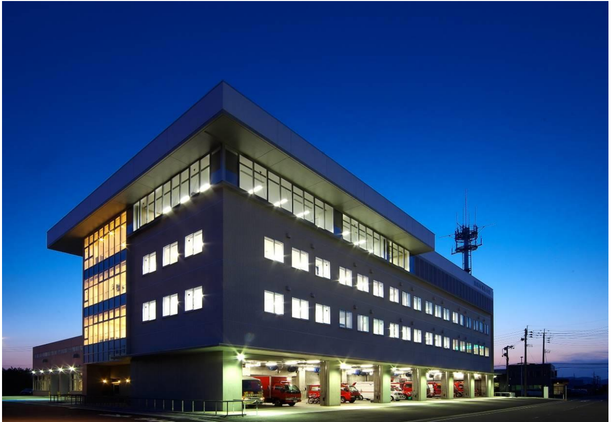
鶴岡市消防本部庁舎
