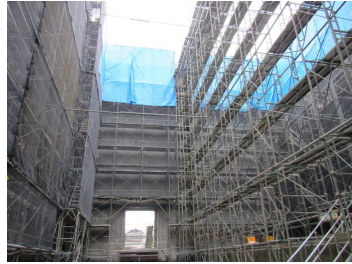
フライタワー施工状況
