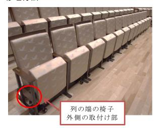
座面の取り付け方法を 溶接ボルトによる固定から ボルトを貫通させた固定方法に変更
