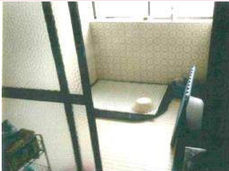
浴室着工前写真
