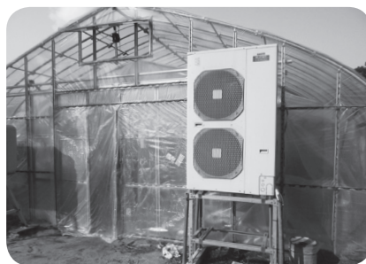
導入したヒートポンプ
