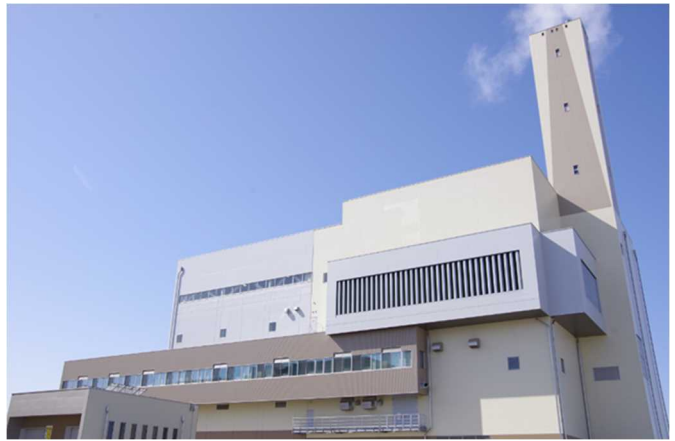
鶴岡市ごみ焼却施設
