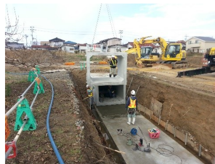
雨水幹線工事状況
