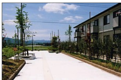
区画整理事業で整備された緑道 (ほなみ町 鶴岡南部土地区画整理事業)
