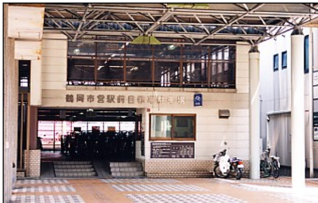
鶴岡駅前公共自転車駐車場
