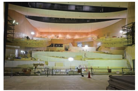
大ホールの施工状況／6月2日撮影
