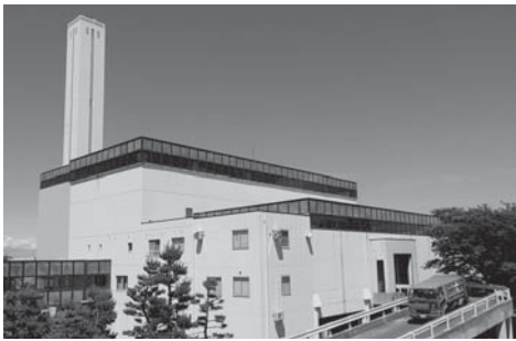
鶴岡市ごみ焼却施設
