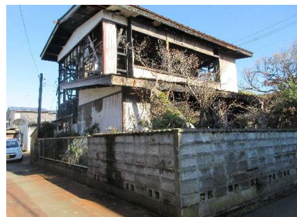
新形町の解体前写真
