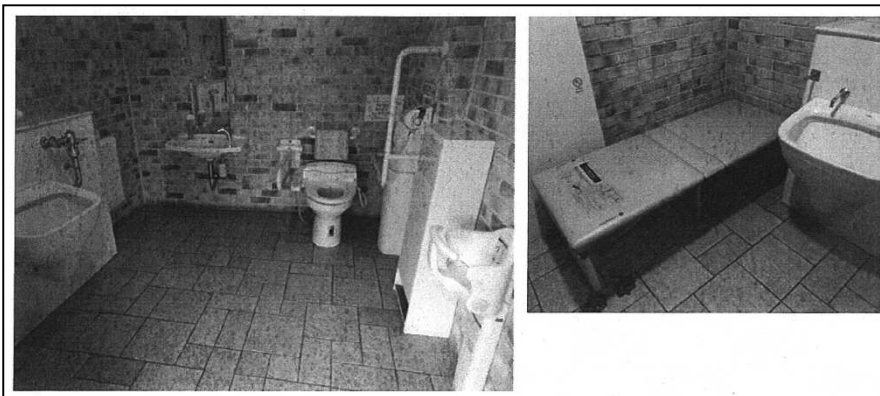
図 導入事例 道の駅「花ロードえにわ」
