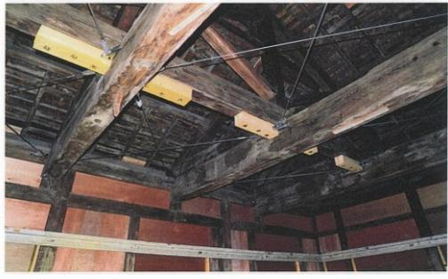
1階小屋裏水平筋違補強状況
