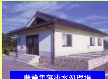
農業集落排水処理場
