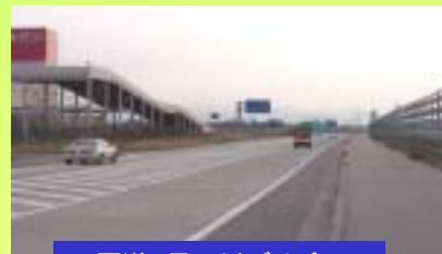
国道7号三川バイパス
