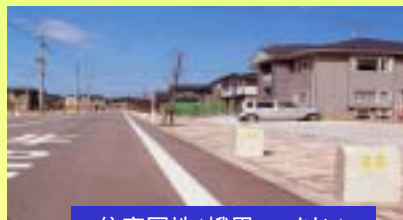
住宅団地(蛾眉ニュータウン)
