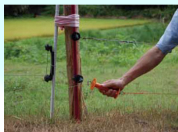
侵入防止柵の設置
