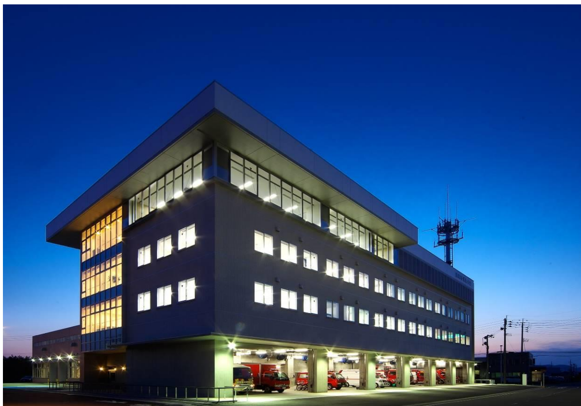
鶴岡市消防本部庁舎
