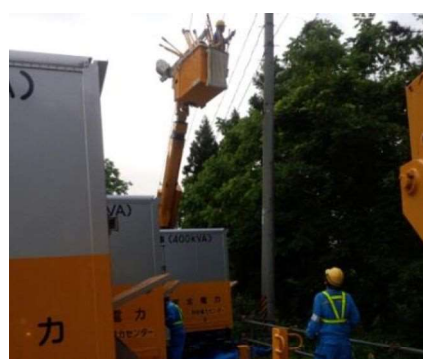
高圧応急電源車の設置状況(鶴岡市小国)
