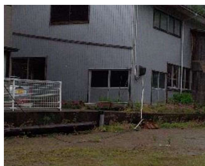
配電設備の設被状況（引込線受点外れ）
