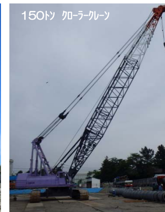
写真：150ト クローラークレーン
