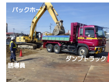
写真：バックホーとダンプトラック
