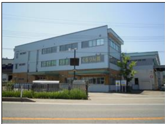
鶴岡市リサイクルプラザ「くるりん館」
