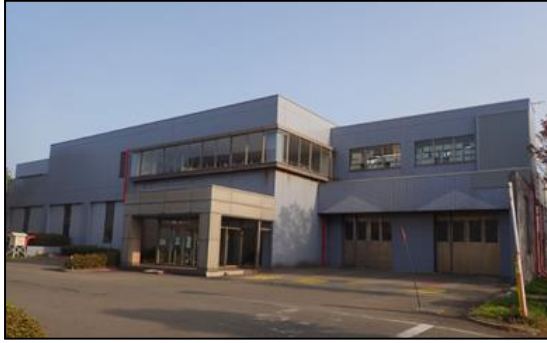
鶴岡市し尿処理施設
