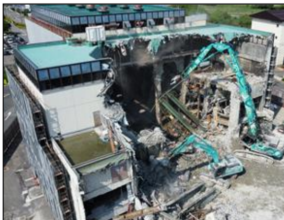
旧ごみ焼却施設の跡地に駐車場等を整備
