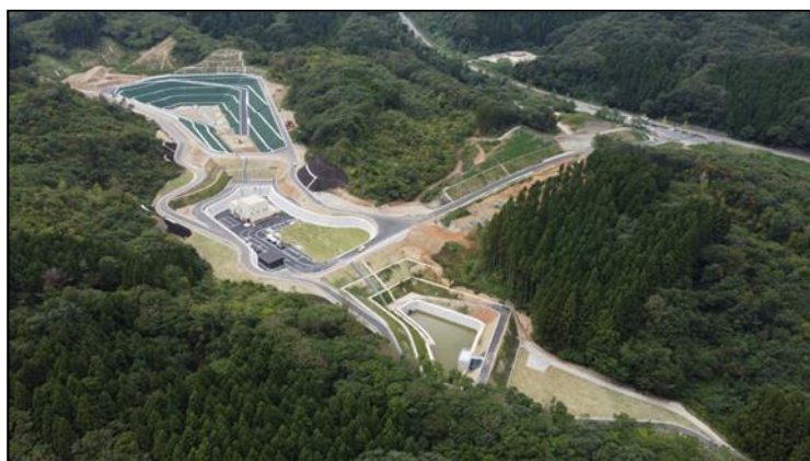
鶴岡市一般廃棄物最終処分場
