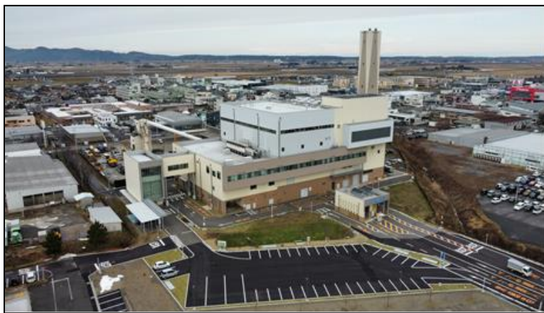
新ごみ焼却施設の一連の整備が完成
