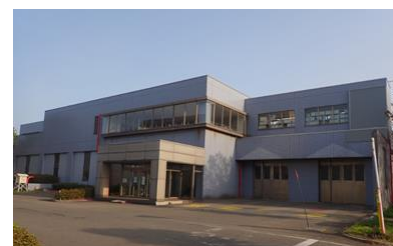
鶴岡市し尿処理施設
