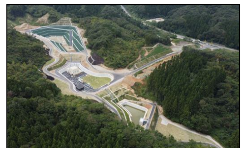
鶴岡市一般廃棄物最終処分場
