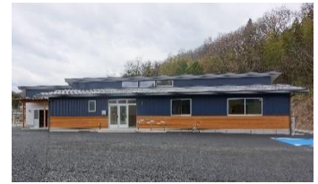
▲最終処分場付帯施設「環境センター」
