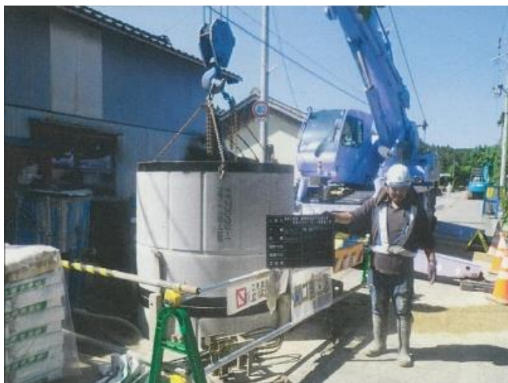
図 1-5 下水道管渠整備状況
