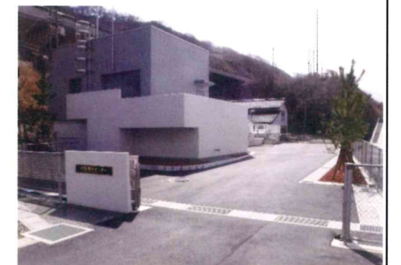
浄化センター正面
