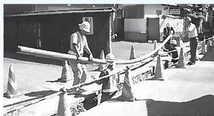
経年化水道管路更新の様子
