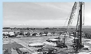
杭打ち工事の様子
