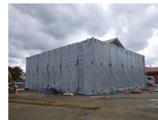
飛散防止足場シート張り状況
