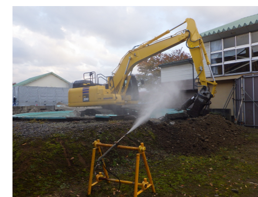
円形プール解体及び散水状況
