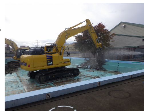
本プール解体状況
