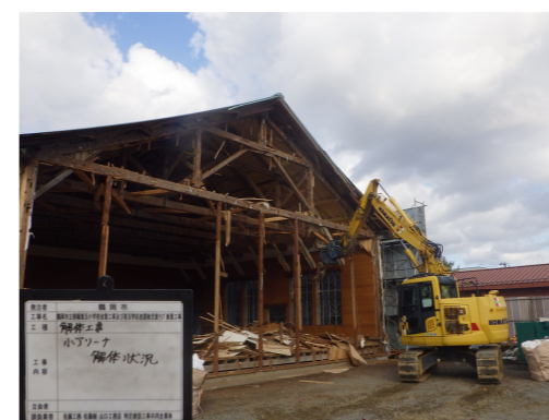
小体育館解体状況
