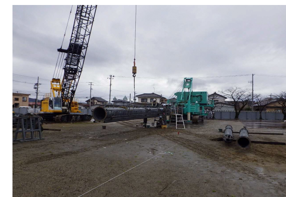
杭打機組立状況
