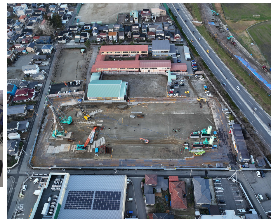
杭施工状況を上空から撮影した写真です。
