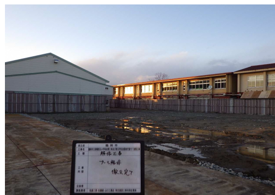
プール解体完了
