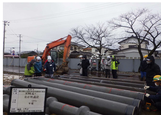
杭材料確認状況
