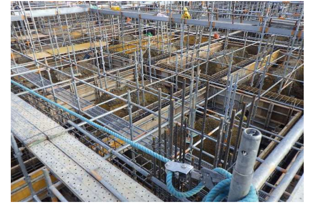
C棟型枠施工状況
