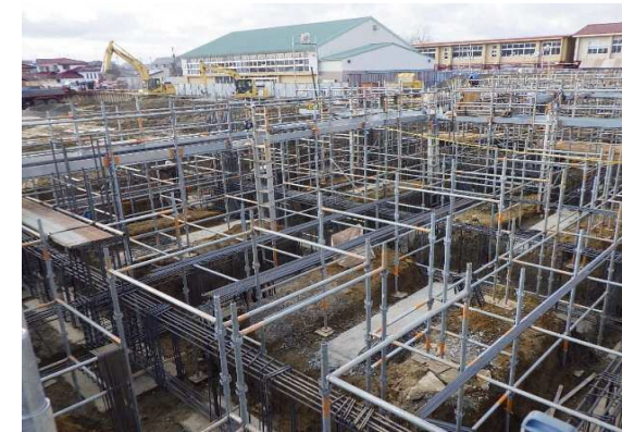
C棟配筋施工状況
