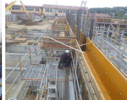
C棟柱・壁型枠組立
