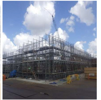
C棟外部足場組立
