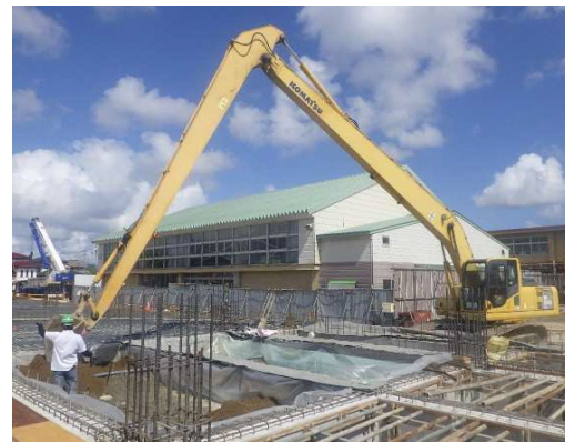
A棟埋め込み状況
