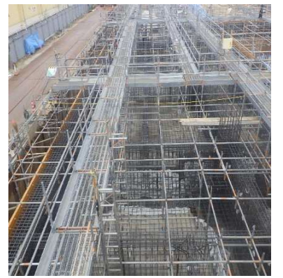
B棟基礎配筋・型枠
