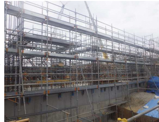
C棟柱・壁配筋
