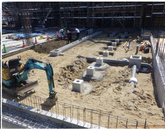
運動広場 外構工事施工状況
