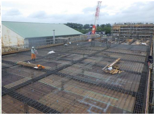
A棟 1階躯体配筋型枠状況
