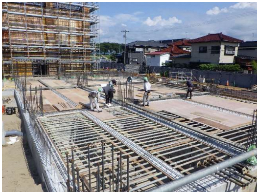
B棟 1F床スラブ施工状況
