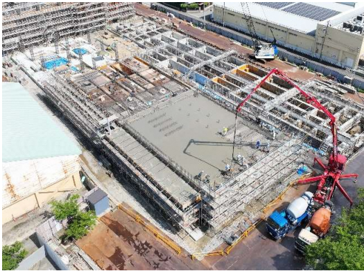
A棟 コンクリート打設状況
