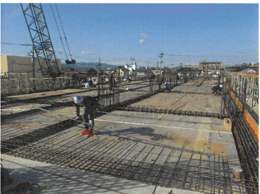
B棟躯体工事状況
