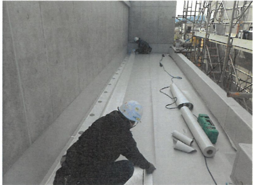
C棟屋上防水工事状況
