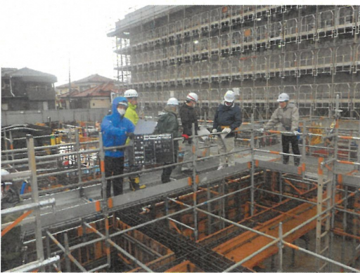
D棟基礎検査状況
