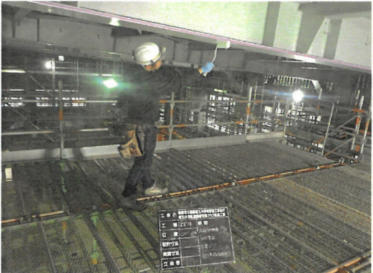
C棟アリーナ天井鉄骨塗装状況
