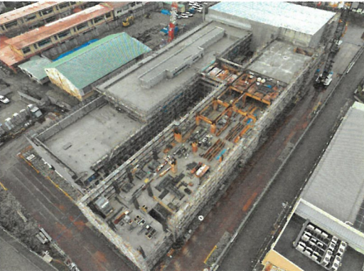
A・B棟躯体工事状況
