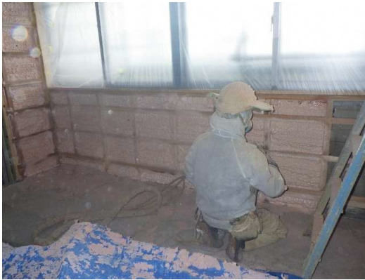
A棟 断熱発泡ウレタン吹付状況
