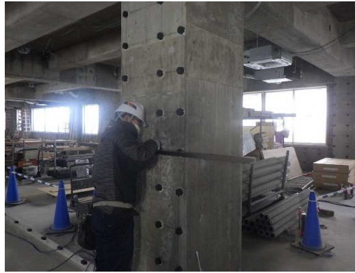
B棟1階 木胴縁受け下地取付
