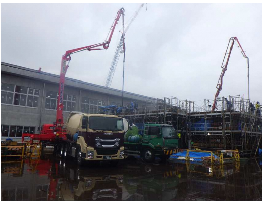
D棟 1階躯体コンクリート打設
