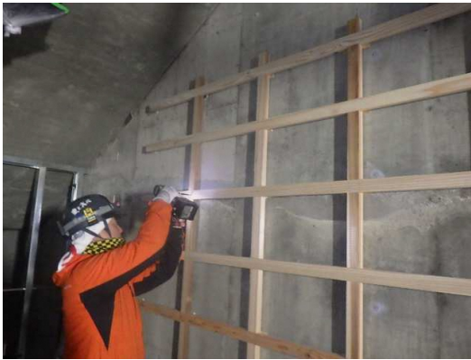
A棟木工事状況
