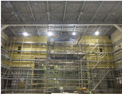
C棟アリーナ壁ボード張り状況
