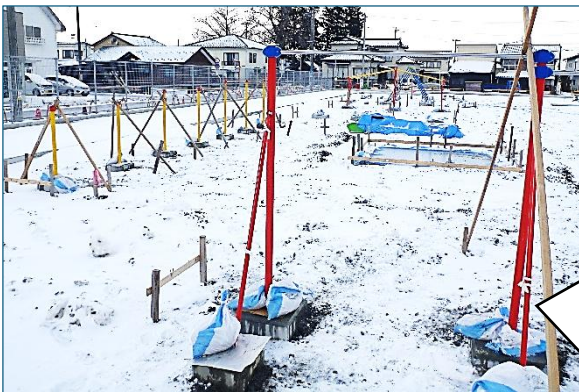
現在のグラウンド工事の様子
