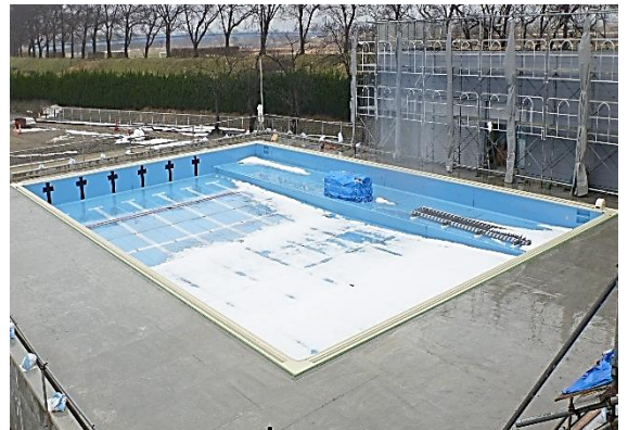
現在のプール工事の様子
