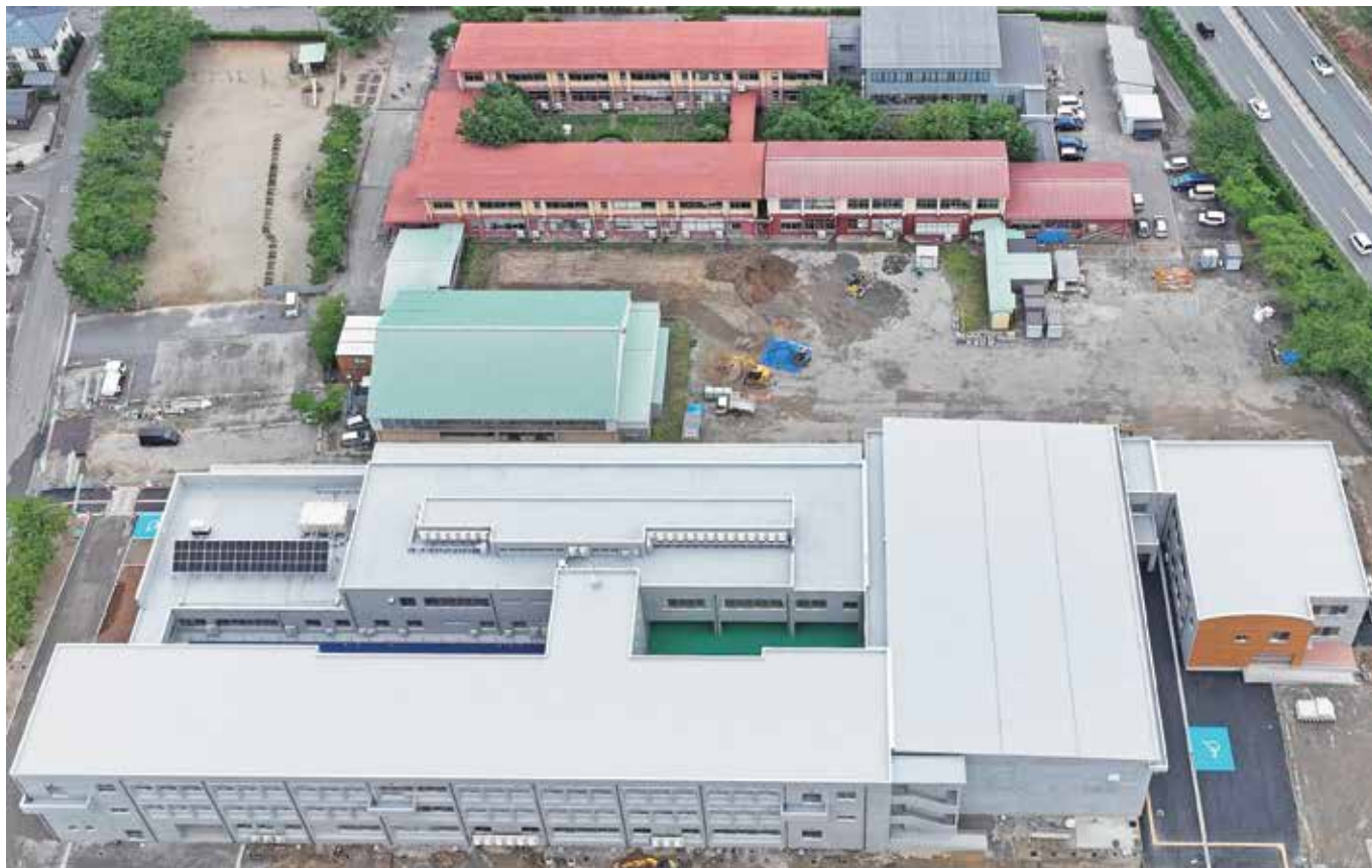
朝陽第五小学校の新旧校舎(ドローン撮影)。旧校舎解体を控え、二つの校舎が並ぶ貴重な一枚です。
