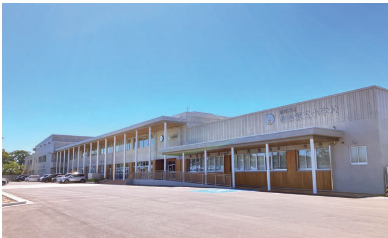
鶴岡市立朝陽第五小学校 新校舎
