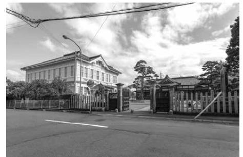
旧東田川郡役所及び郡会議事堂
