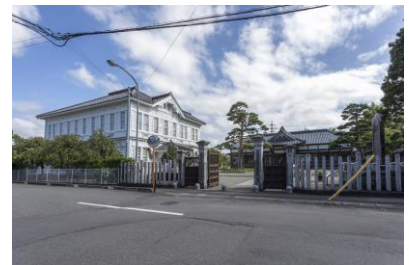
旧東田川郡役所及び郡会議事堂
