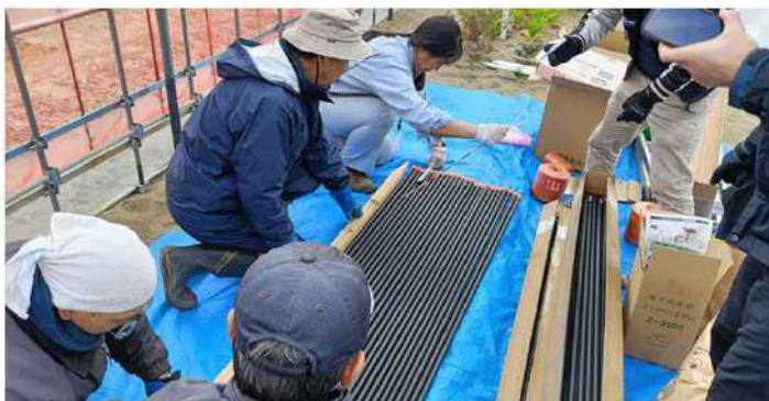
(電気柵の設置作業)
