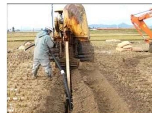
暗渠排水（地下かんがい）
