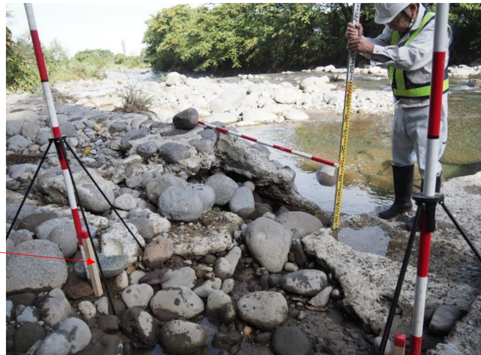
水路(石積)の流出 1.6 \times 1.5 \times 0.3\text{m}
