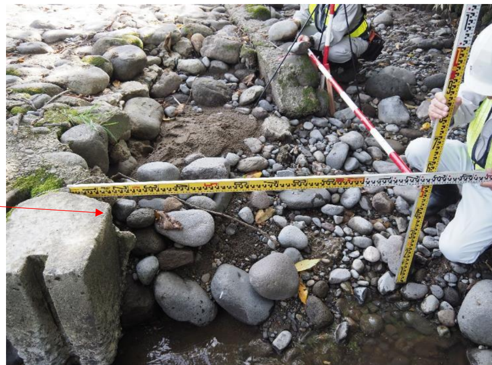
水路(石積)の流出 1.4 \times 1.2 \times 0.5\text{m}
