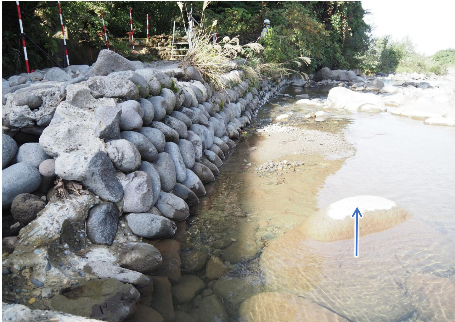
⑩横断写真 No 0+9.2～起点方向 水路部河川側
