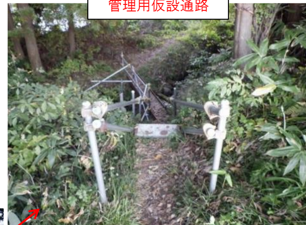
管理用仮設通路
