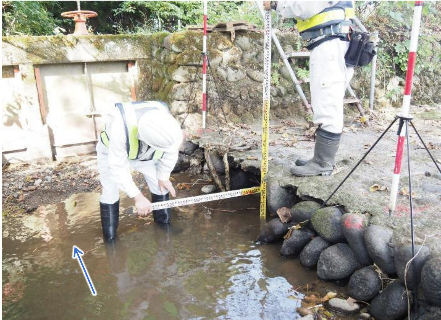
⑨横断写真 NO.0-4.0(-5.0) 水路部護岸側
