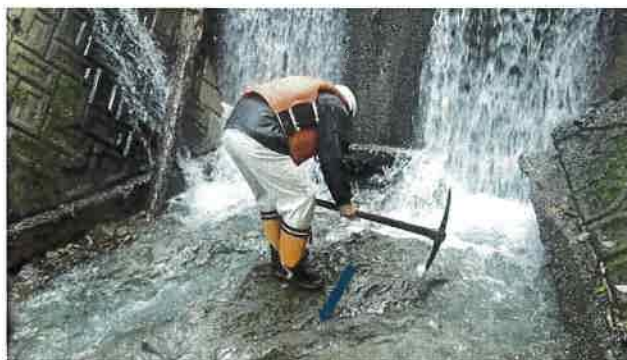
被災箇所河床 ㉒
