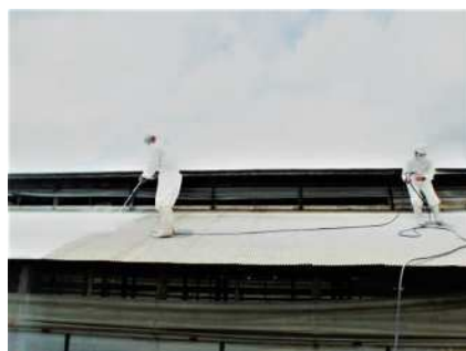
屋根へのドロマイト石灰塗布
