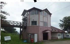
桜づつみの展望塔ですが、現在は、1階のトイレ、足洗い場のみ開放しています。
