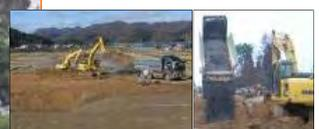
掘削土砂は、築堤等に有効利用します。
