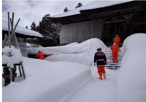
(令和8年1月25日 重要文化財 羽黒山正善院黄金堂)
