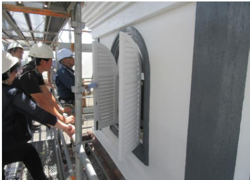
旧西田川郡役所(塔屋)
