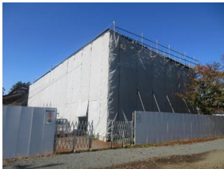
R7より貯桑土蔵全体を囲い、保存修理工事を開始。
