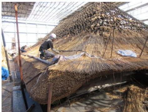
屋根葺替(1期目)
