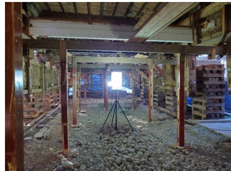
ジャッキアップ状況。本舎を約1メートル程上げ、調査を行った上で基礎土台や柱の根継ぎを行う。
