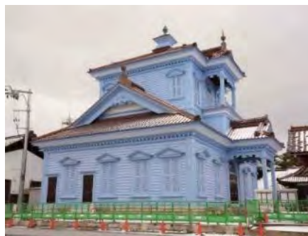
重要文化財 旧鶴岡警察署庁舎
