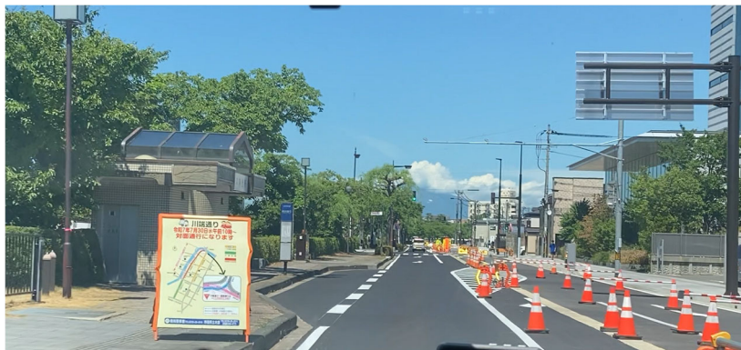
図 2-1-1 川端通りの一方通行規制解除前の様子(北向き)
