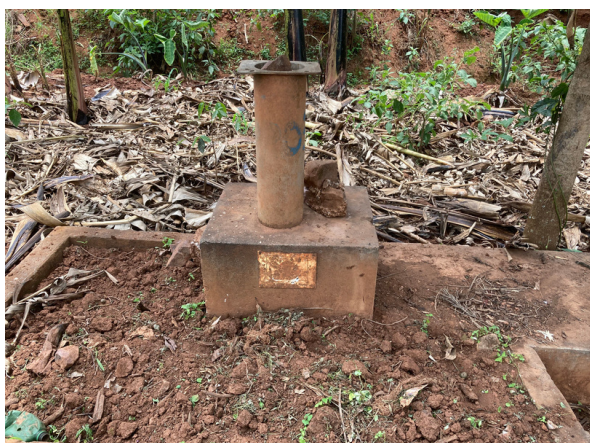
※ 故障後放置された井戸①
