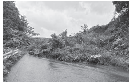
法面崩落直後の市道 宮の下宝谷線
