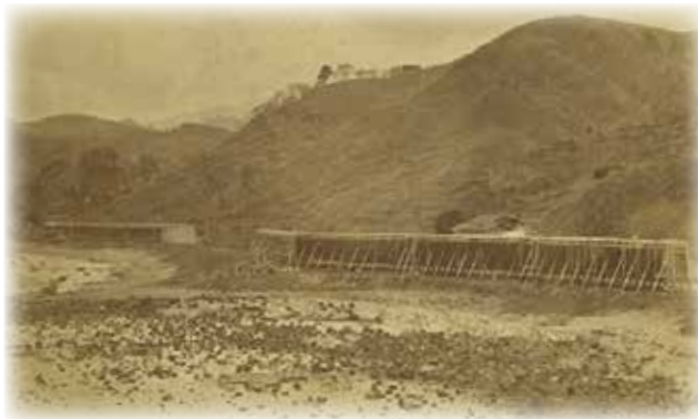
▲枝条架法の製塩器
